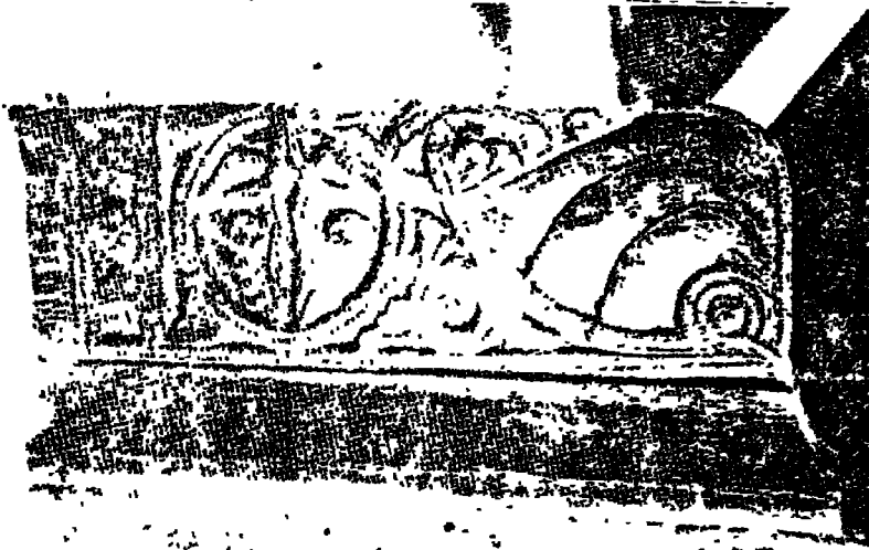
أ - ركنة أندلسية من طليطلة مصنوعة من الخشب يرتكز عليها السقف الخشي بكنيس سانتا ماريا لابلاسكا بطليطلة
